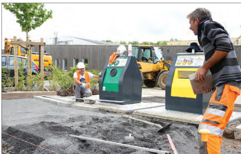
Bornes d'apport volontaire enterrées installées à l'écoquartier.
