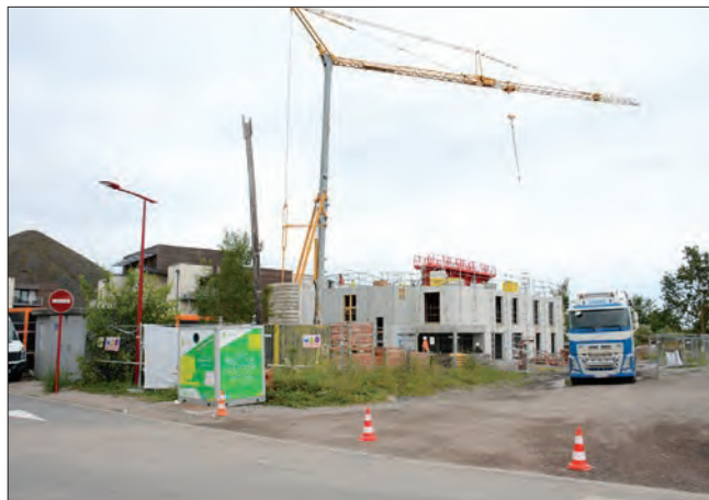
Les travaux de la Résidence sociale sont commencés.
