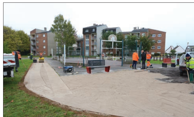
Une grosse partie des travaux réalisés par nos agents municipaux
