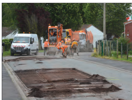
Avant l'enrobé, des purges sont parfois nécessaires.
