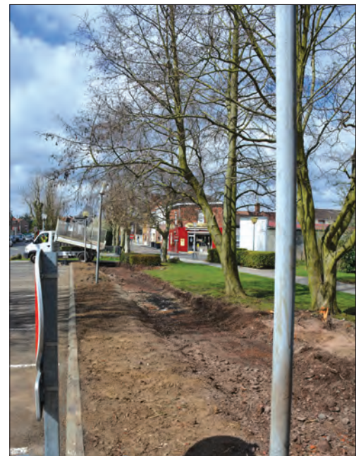
Réaménagement de la place Jean XXIII où les écoliers ont planté des vivaces.
