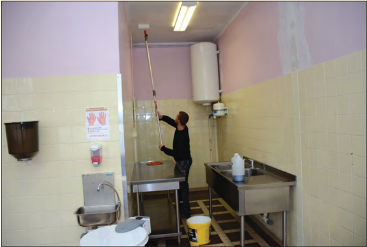
Remise en peinture : Les vacances scolaires sont mises à profit pour effectuer des travaux d'entretien dans les établissements scolaires.
