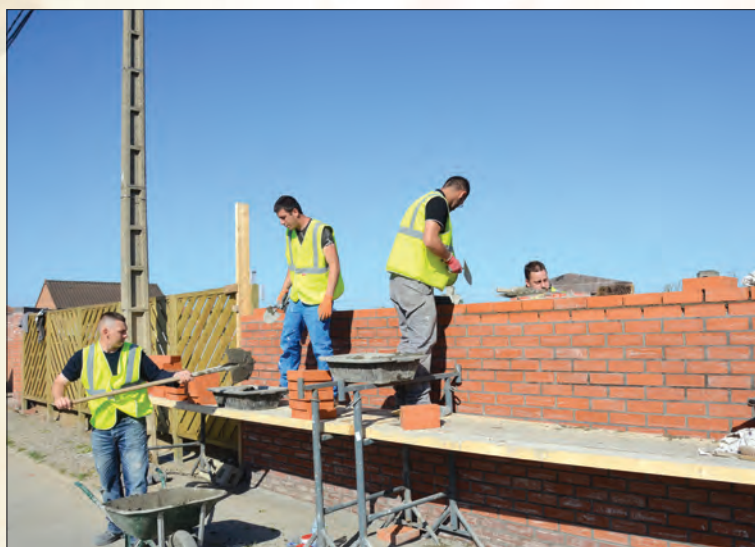
Chantier Insertion Professionnelle
