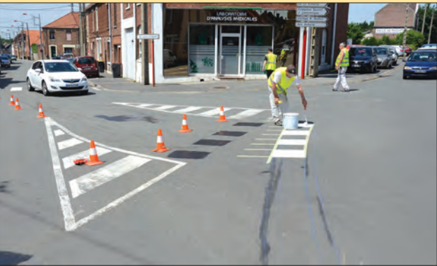
Peintures au sol : Chaque année, les services municipaux profitent des beaux jours pour rafraîchir les marquages au sol des emplacements de stationnement, des passages protégés ainsi que la signalisation des carrefours. Un travail nécessaire pour la sécurité des usagers et pour permettre un bon respect du code de la route.
