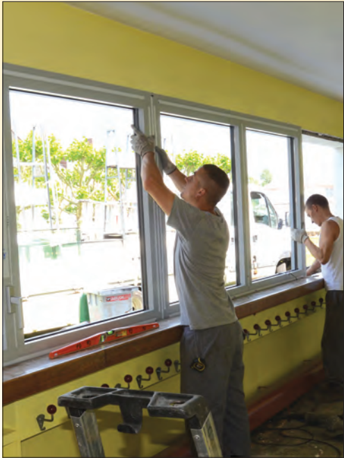
Travaux dans les écoles : Comme chaque année, la période des vacances va permettre d'effectuer des travaux dans les écoles : remplacements des huisseries à la maternelle Neveu, à l'école Mermoz plus macadam dans la cour et entretiens courants dans les autres bâtiments scolaires.
