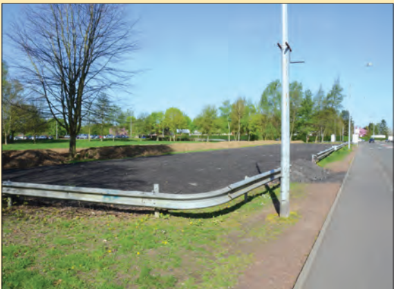
Pas toujours facile de trouver une place de stationnement lors des grands événements sportifs ou culturels. Avenue Jeannette Prin, la ville entreprend la réalisation d'un parking de proximité offrant 60 places supplémentaires qui seront bien utiles pour les usagers de l'Espace Jules Ladoumègue, du collège Henri Wallon, de l'école Pierre et Marie Curie ou de la salle Marc Lanvin.
