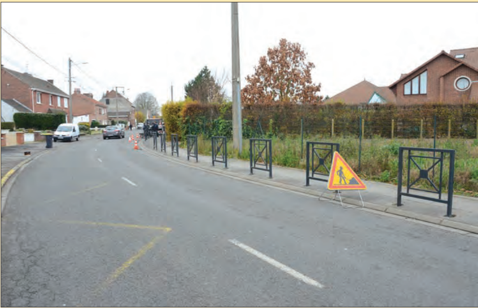
Sécurité : Avec le souci de toujours améliorer la sécurité des citoyens, des barrières ont été posées aux abords des trottoirs rue Camille Desmoulins à des endroits jugés critiques et fréquentés quotidiennement par les écoliers.
