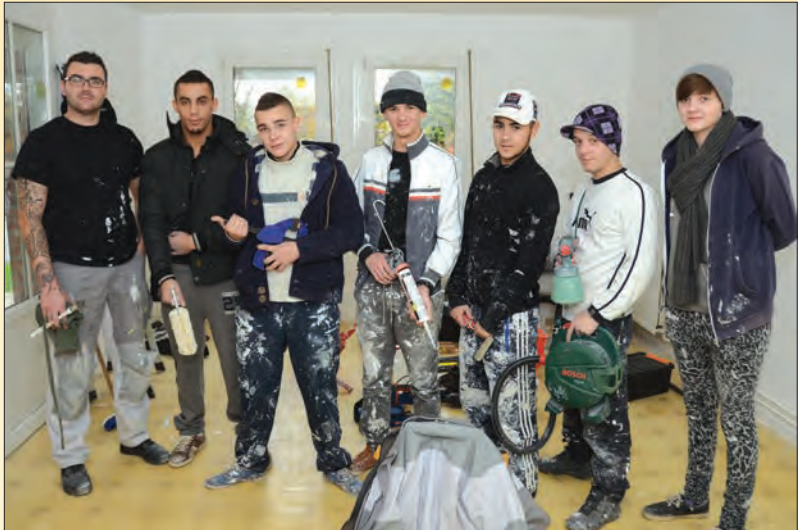
Chantier Ecole : Dans le cadre d'un chantier d'insertion professionnelle, des jeunes ont rénové quatre logements du foyer résidence Henri Hotte. Durant un mois, ils étaient six à entreprendre une rénovation complète, du sol au plafond, dans quatre appartements. Conseillés et encadrés par le peintre de la ville, le groupe a produit un excellent travail dans le domaine de la peinture. Les nouveaux résidents qui aménageront dans ces logements n'auront plus qu'à poser leurs meubles.
