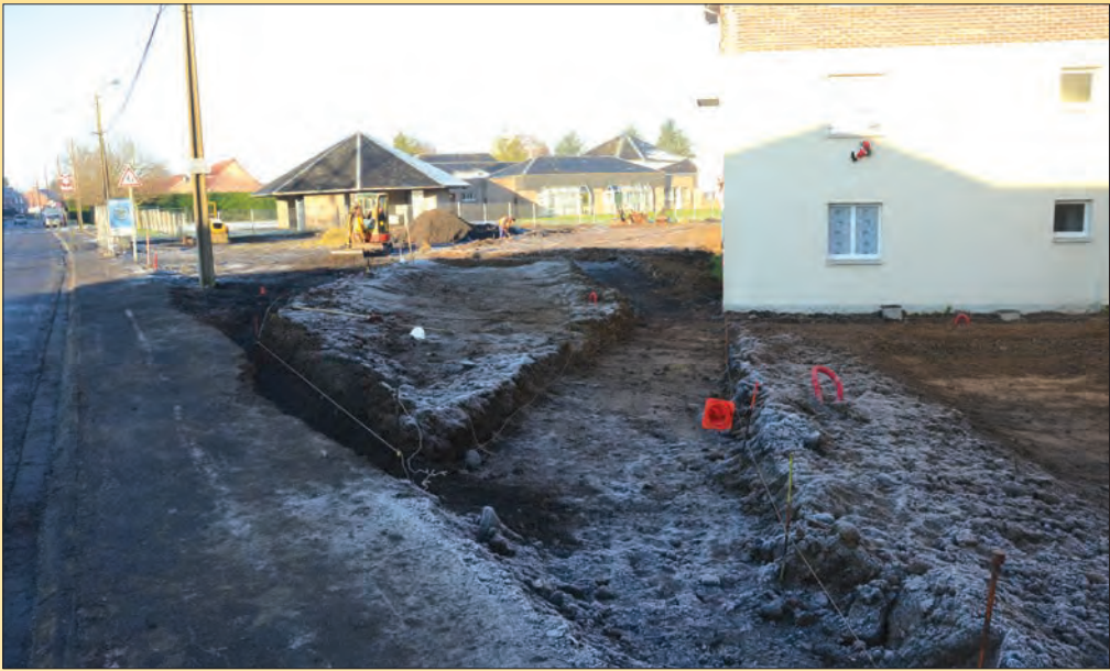
Parvis à l'école Mandela : Les travaux ont enfin démarré aux intersections des rues Camilles Desmoulins et Dulcie September où va être réalisé un parvis surélevé afin de réduire la vitesse d'une part et de sécuriser l'entrée de l'école Nelson Mandela ainsi que l'accès aux résidences Brink et Tutu. Accessible par la rue Condorcet, le parking de 12 places existantes va être agrandi de 13 places supplémentaires dont une pour personnes à mobilité réduite. Des aménagements paysagers seront réalisés en 2014 au démarrage de la période végétative.
