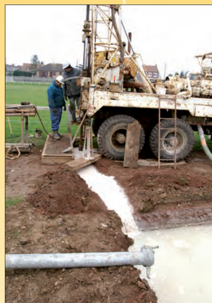
Forage pour alimenter en eau les WC, les machines à laver et l'arrosage du terrain
